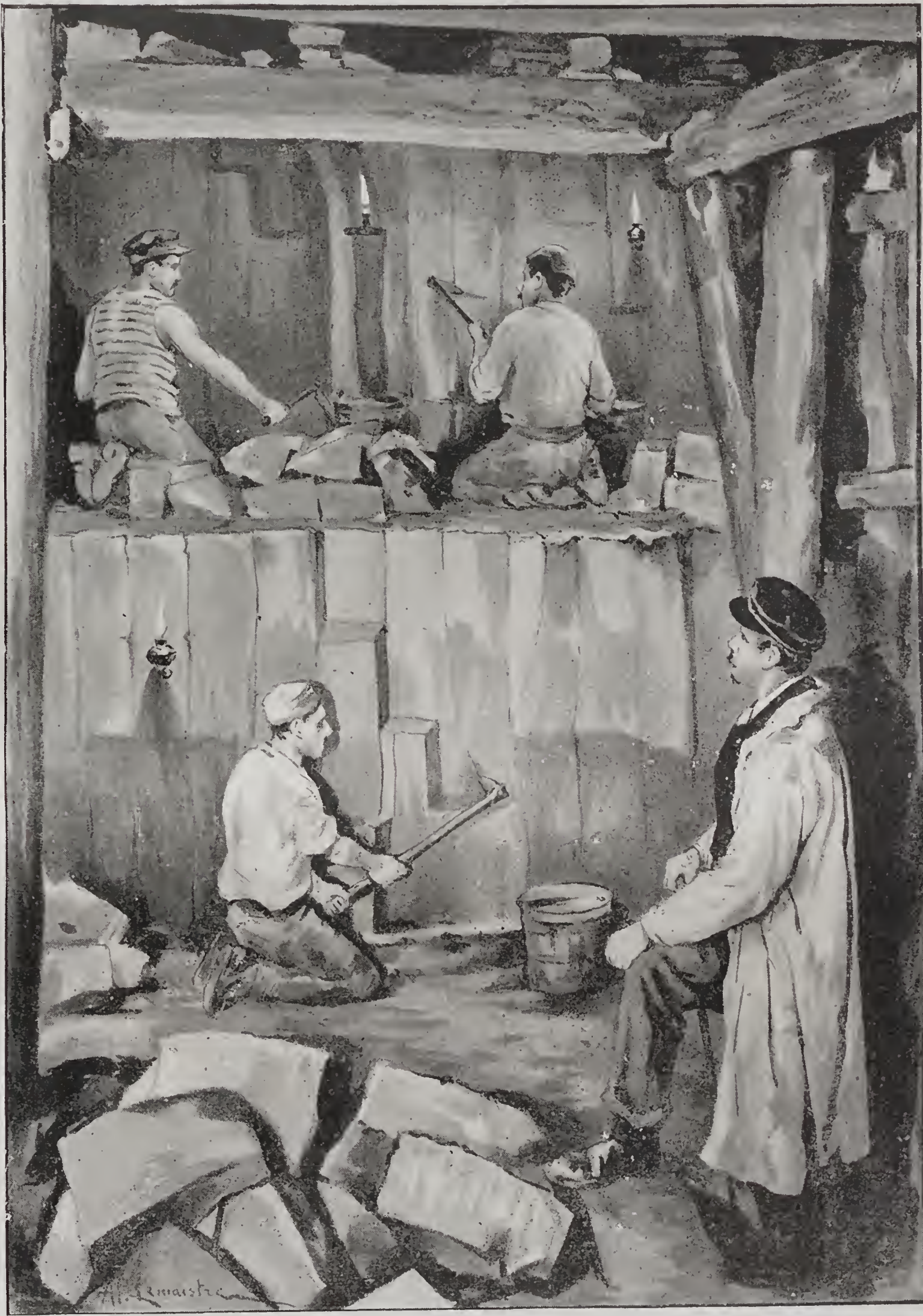
LA LIGNE COURCELLIS-CHAMP-DE-MARS. — Extraction de l'argile, en exécution d'une galerie transversale pour l'entretoisement des pieds-droits de la voûte.
